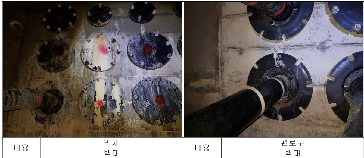
【사진 7.30】 맨홀 내부 주요 손상
